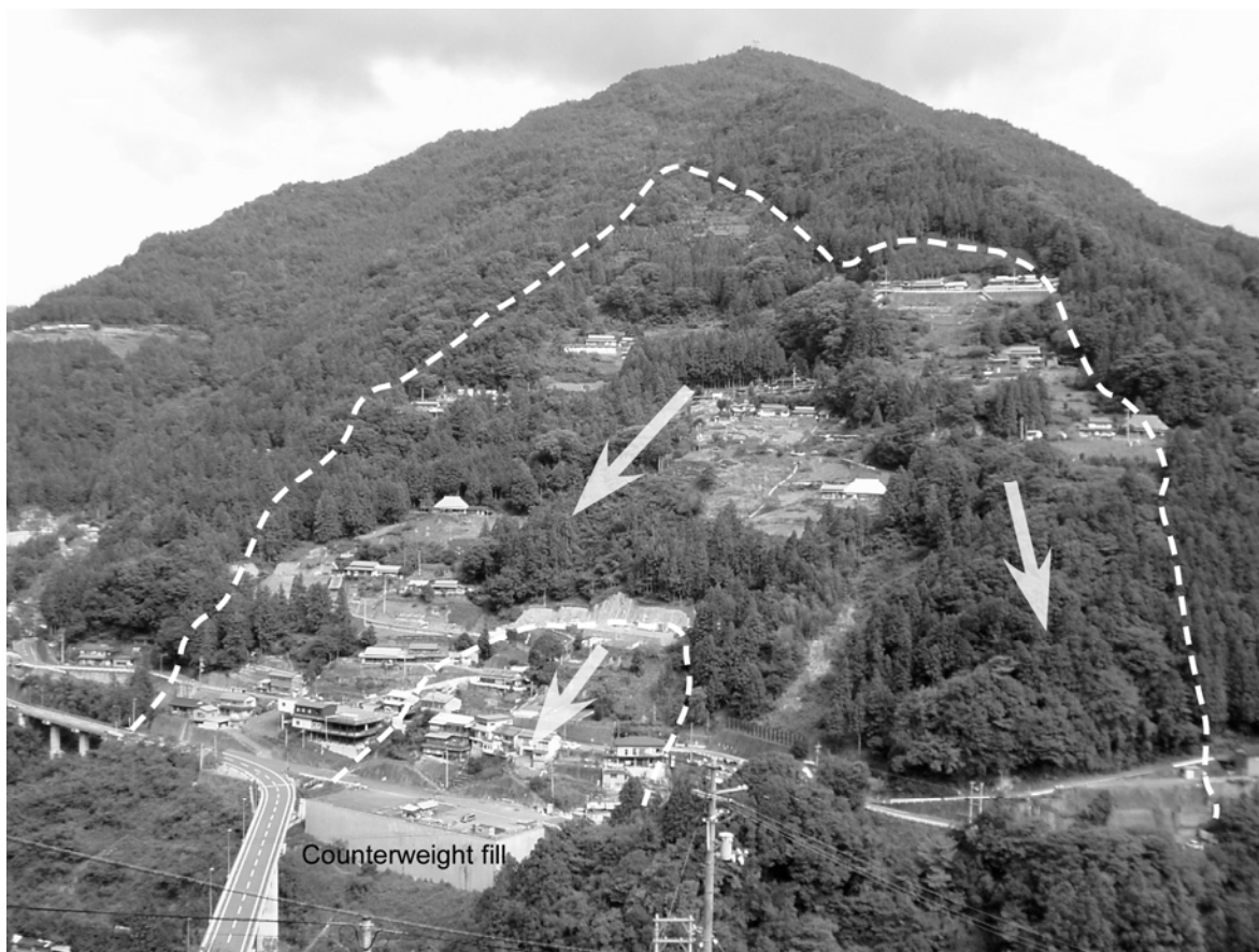
図-1 徳島県三好市西祖谷の善徳地すべり地。複数の岩盤すべりの集合体の外側輪郭を示している。特に活動的であった岩盤すべりブロックの下方に巨大な抑え盛土がある
